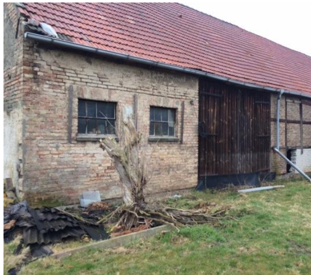
Abb. 4: Außenansicht der Scheune „Staffelder Dorfstraße 16“
